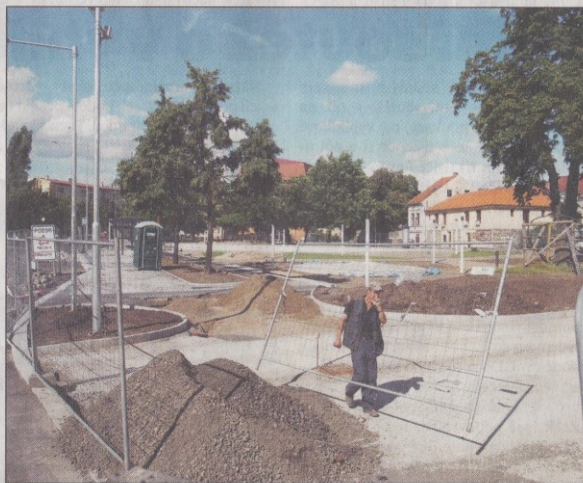
Studentské náměstí v minulých dnech, kdy zbývalo položit dlažbu v ulici Jana Švermy a provést vodorovné dopravní značení. Současně s tím probíhaly dokončovací práce zahrnující montáž mobiliáře plus terénní a sadové úpravy.
