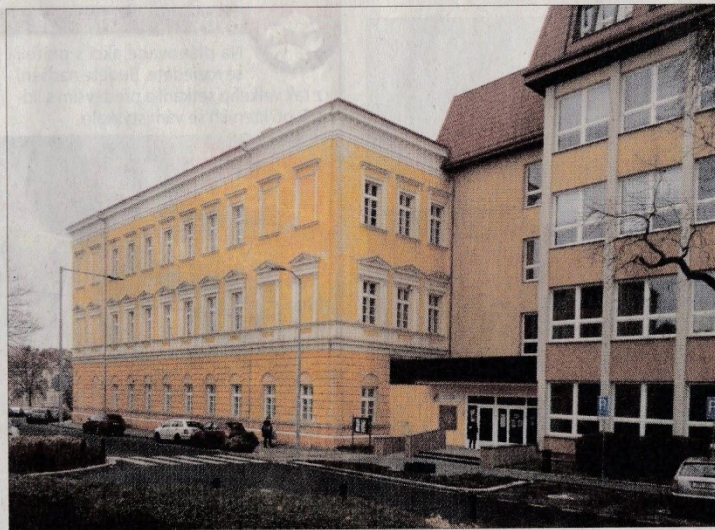
▲ Stará a část nové budovy kadaňské „stavebky“
